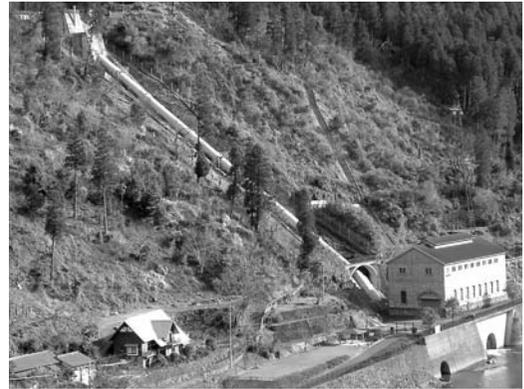
写真0-3 落差をエネルギーに変える水路式水力発電所
