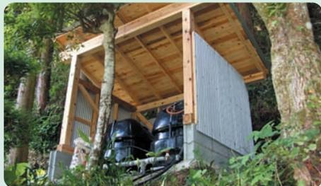
(a) 水圧を確保するため5.6m高い場所に設置した給水タンク
